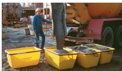
Kubel budowlany przy napełnianiu
